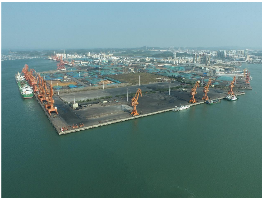
图 3.4.3-3 钦州港钩达散杂货码头项目现状图
