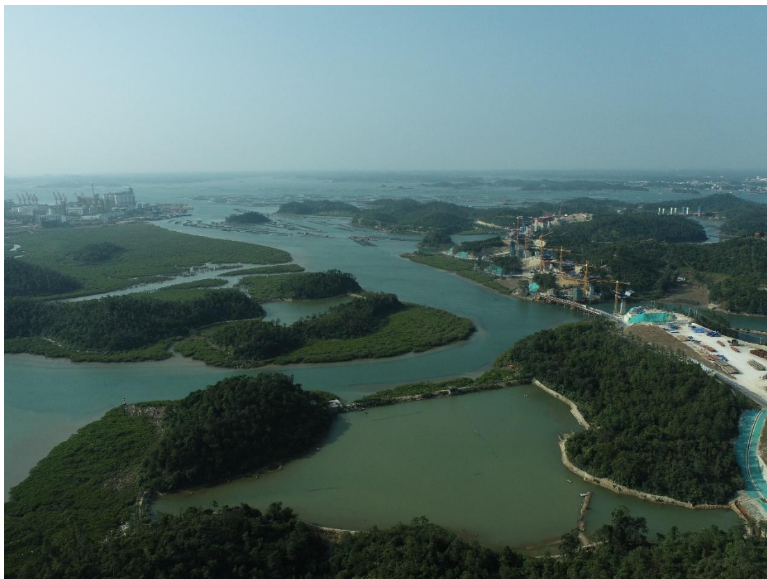
图 3.4.3-2 广西滨海公路龙门大桥工程现状图
