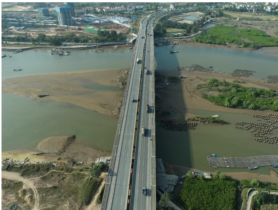
图 3.4.3-1 沙井钦江大桥现状图
