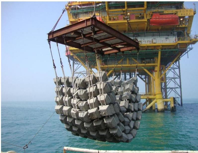
图 2.3-13 水泥压块保护示意
