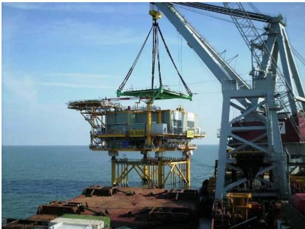
图 2.3-9 海上升压站整体吊装示意图片
