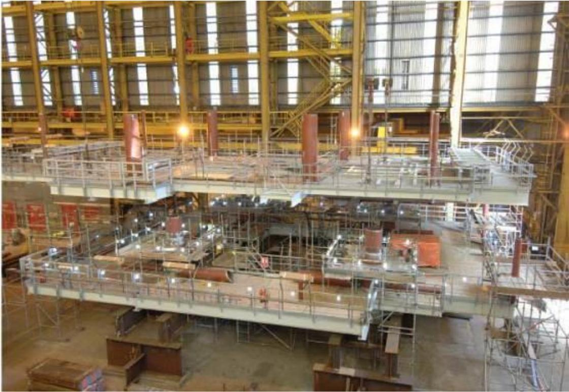
图 2.3-5 海上升压站整体加工制作示意图
