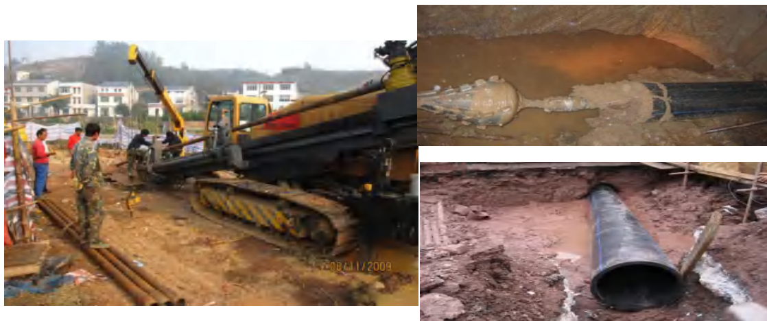
图 2.3.1-5 定向钻机、定向钻头和定向钻穿管照片
