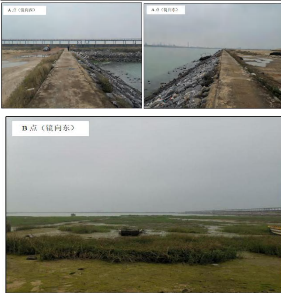
图 3.4.2-6 涉海段 1 两侧现状照片
