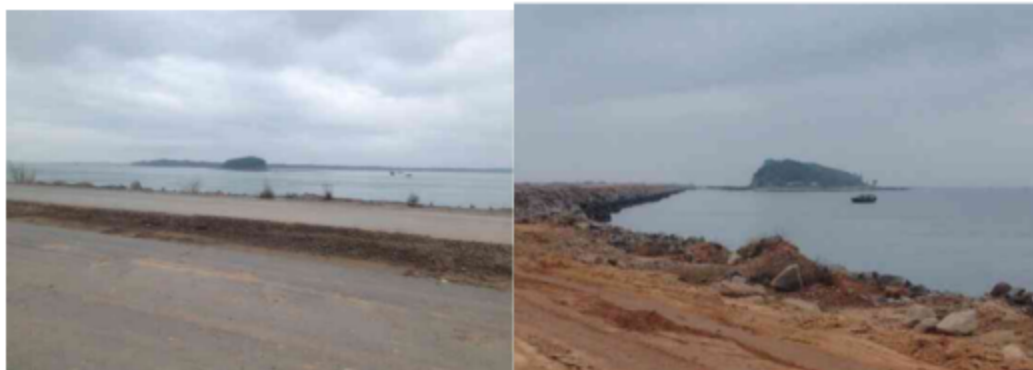
图 3.3.8-1 三墩及三墩公路
