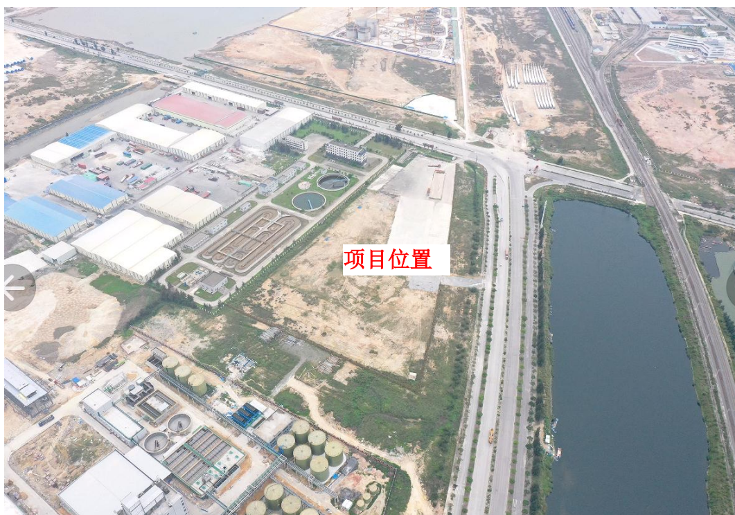
图 2.6-1 工程区域及周边现状
