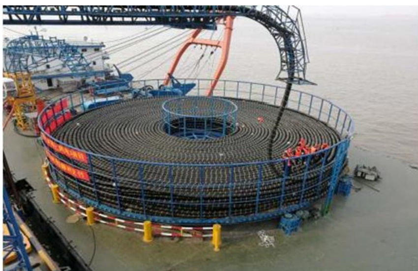
图 2.3.4-2 海缆装船示意图
