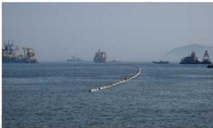
(b)海缆绑扎泡沫浮筒敷设示意图
