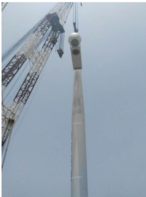
图 2.3.2-3 机舱安装示意图
