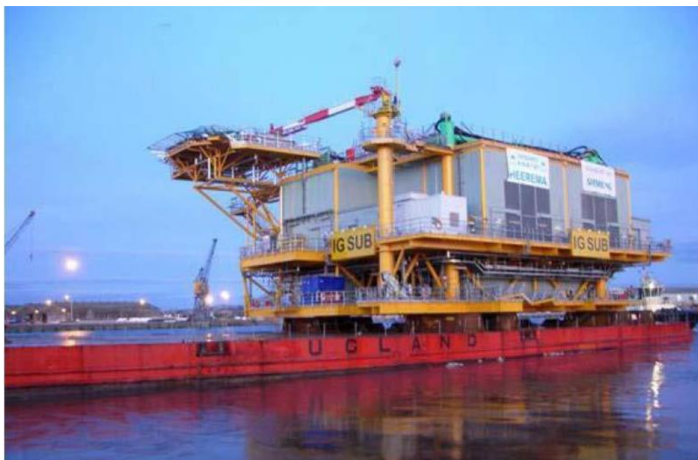
图 2.3.3-6 海上升压站整体运输示意图
