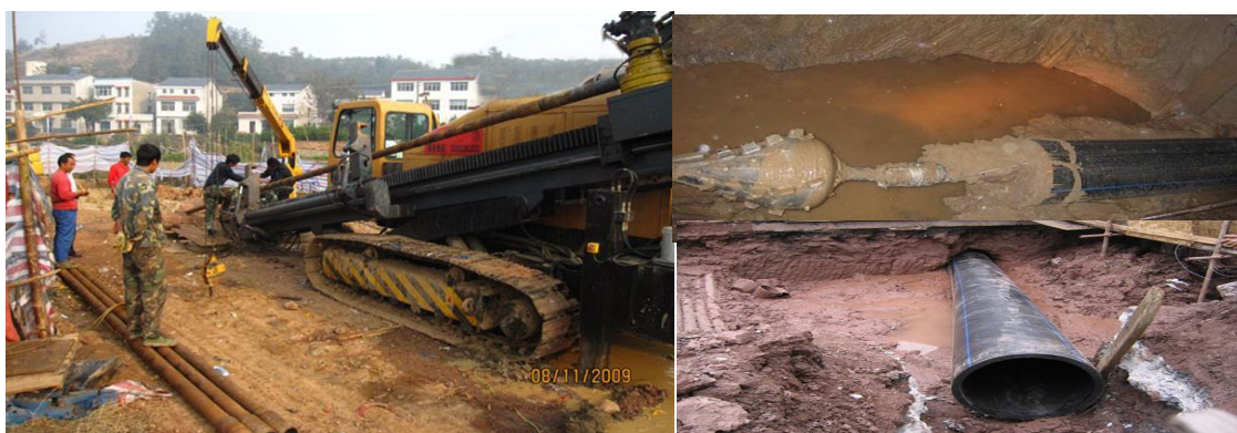
图 2.3.1-5 定向钻机、定向钻头和定向钻穿管照片
