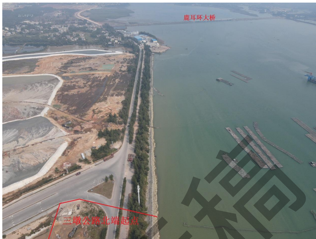
图 5.1-3 项目北端起点附近现场照片（2023.11.24）
