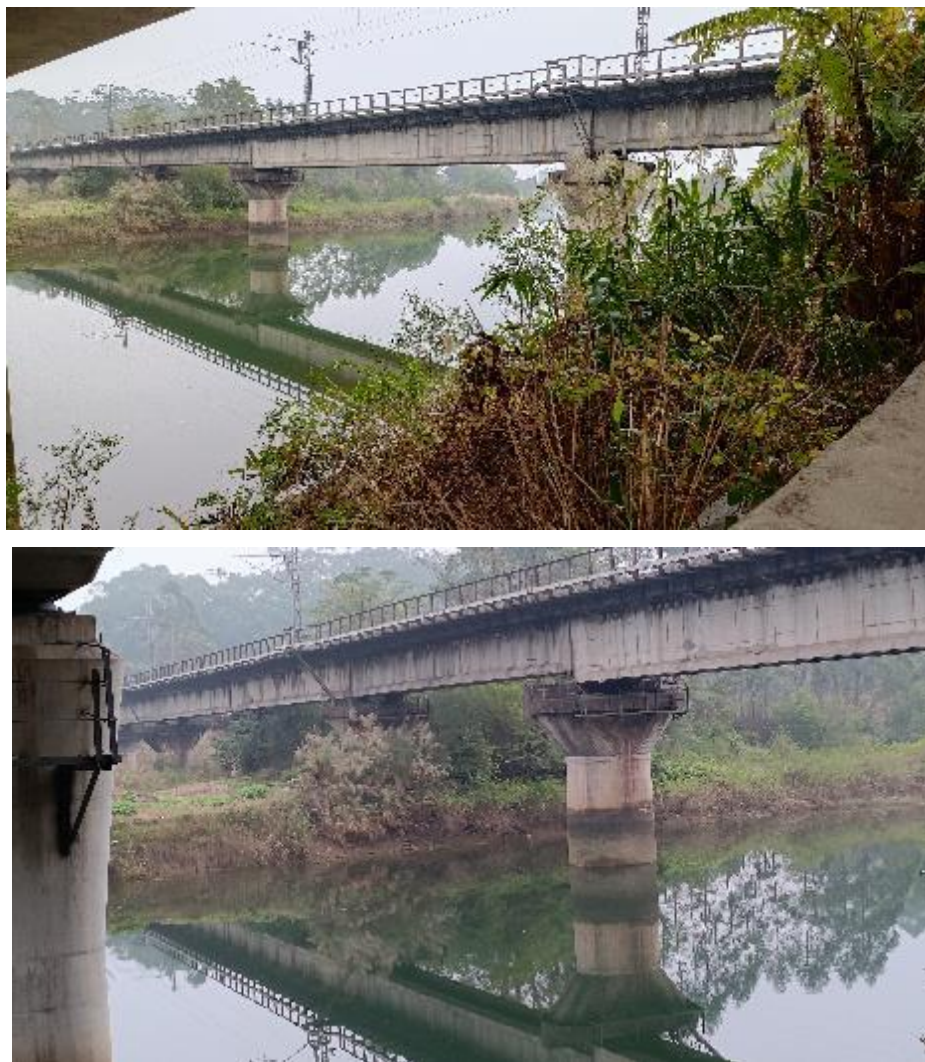
图5.2-6 金鸡塘江大桥两岸植被情况
