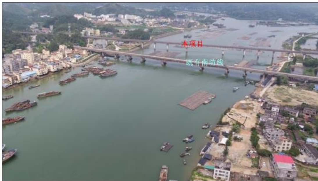
图5.1-3 跨海桥梁现状图（茅岭江特大桥海域，由南向北拍摄）
