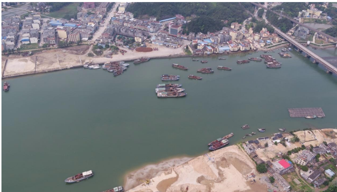
图5.1-5 茅岭码头现状（由东向西拍摄）
