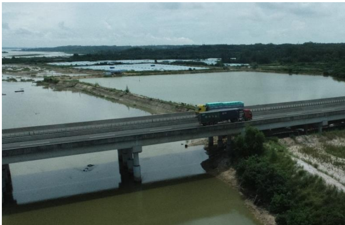
图 5.1-4 项目现场勘察照片（桥南侧接岸线段）
