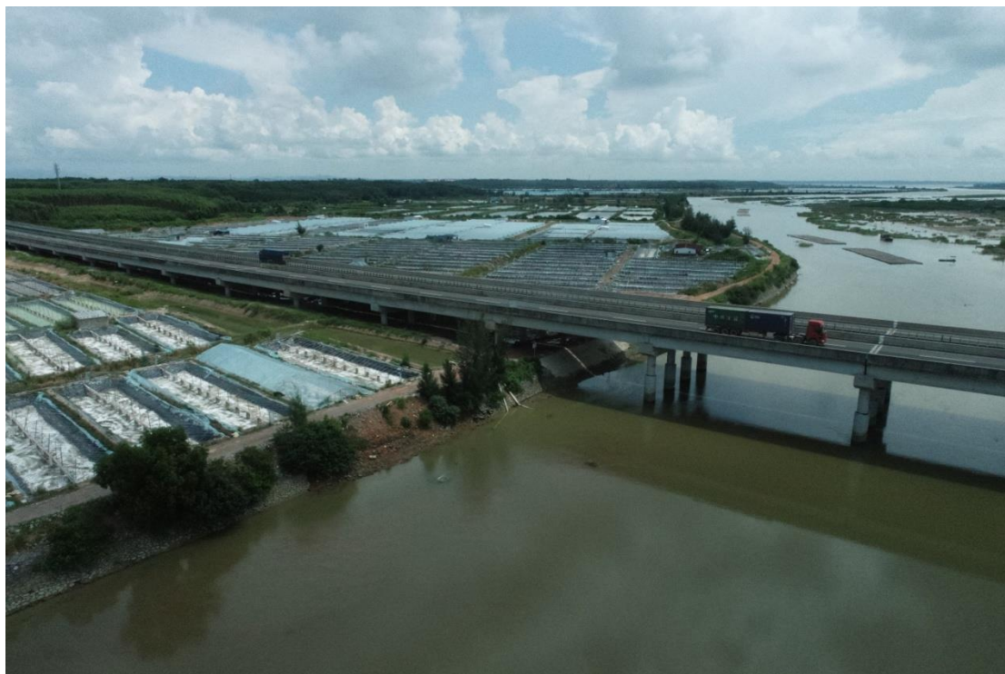
图 5.1-5 项目现场勘察照片（桥北侧接岸线段）
