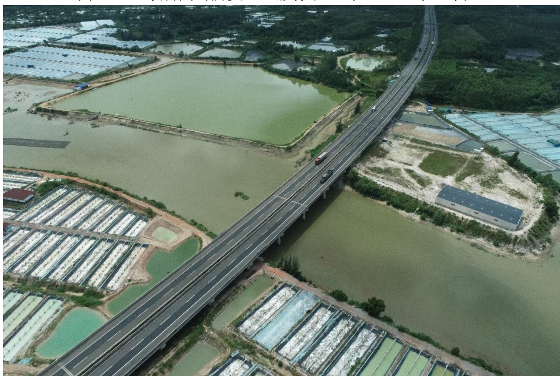
图 1.1-2 白沙头港大桥现场勘察航拍照片（2023 年 9 月 19 日）
