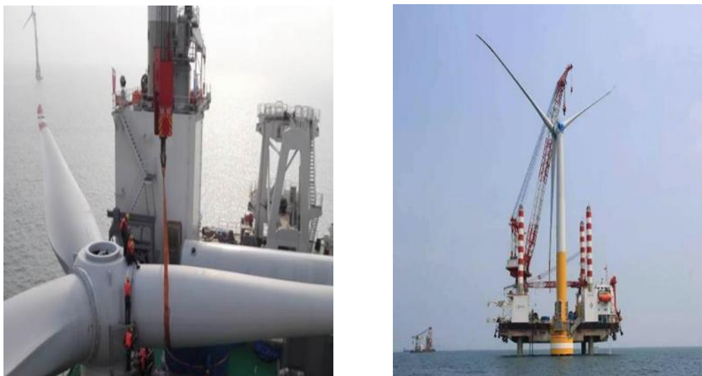
图 2.3.2-4 叶片安装
