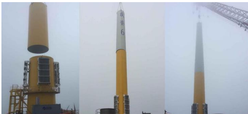
图 2.3.2-2 塔筒吊装示意图
