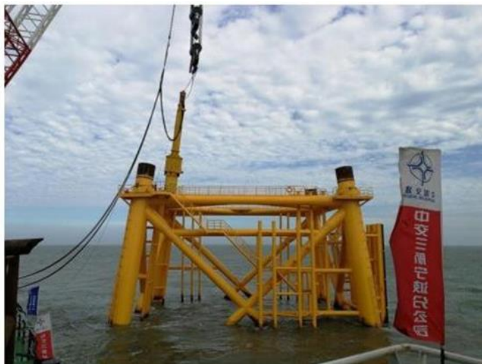
图 2.3.3-3 起重船吊打施工示意图
