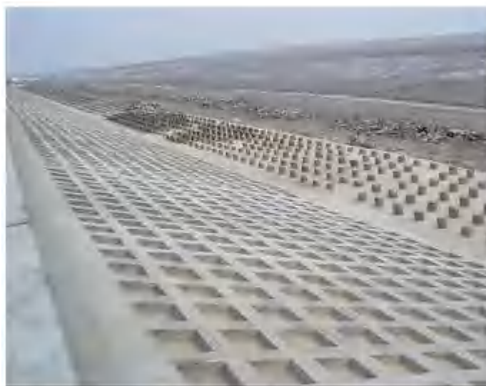
图 7.2-2b 砣框格护坡图
