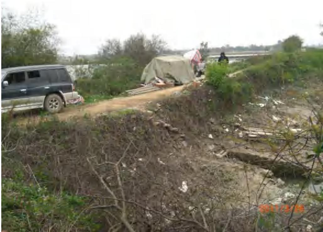
图 2.1-3 旧堤岸坡崩塌严重
