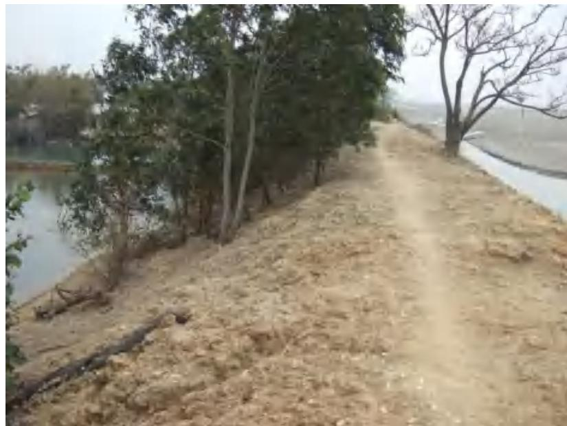
图 2.1-4 旧堤身水土流失严重，造成土堤沉降变形
