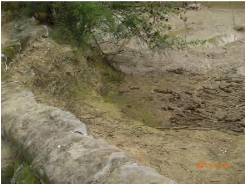
图 2.1-2 旧堤岸坡崩塌严重
