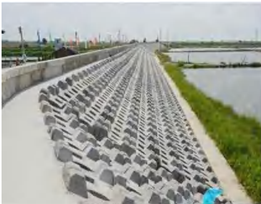
图 7.2.1-3e 四脚空心砖护坡
