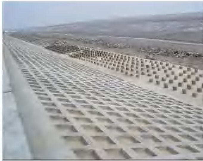
图 7.2.1-3c 砼框格护坡图
