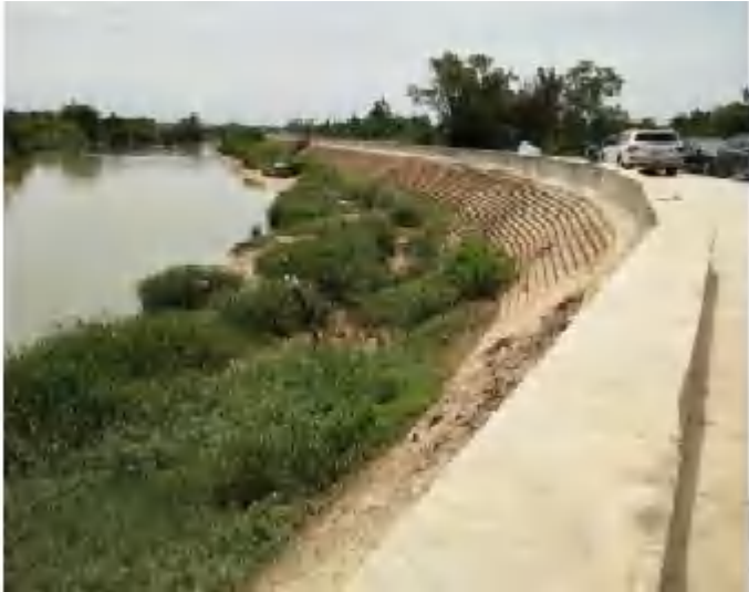
图 7.2.1-3a 砼阶梯出海口河堤（推荐）效果图
