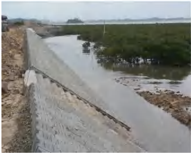
图 7.2.1-3b 连锁式混凝土预制块护坡效果图
