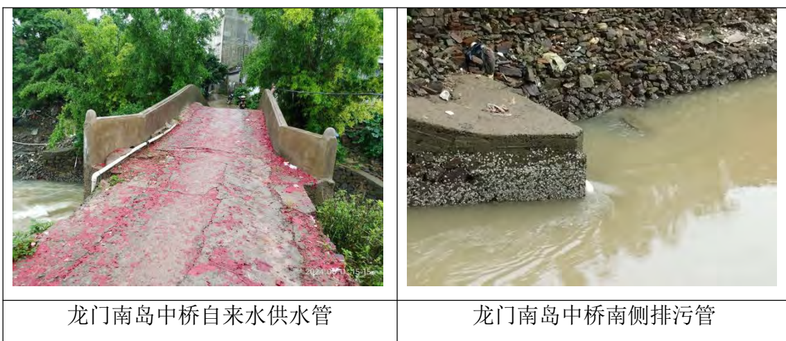
图 5.1.2-7 项目区自来水供水管和排污管现状照片
