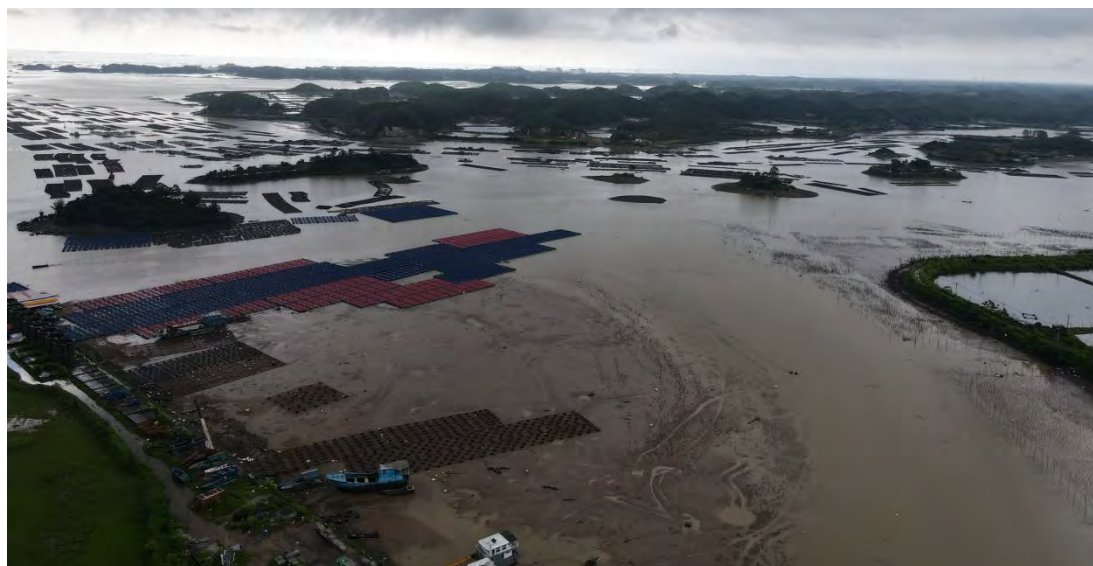
图 5.1.2-1g 本项目潮汐通道疏通工程南面用海区现状（从北向南拍摄）
