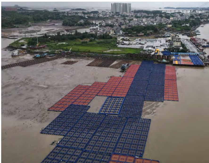
图 5.1.2-12 钦州市龙门岛陆岛运输码头工程项目(未建)现状照片
