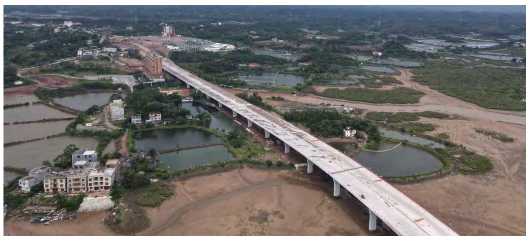
图5.1.2-3 广西滨海公路龙门大桥工程现状图
