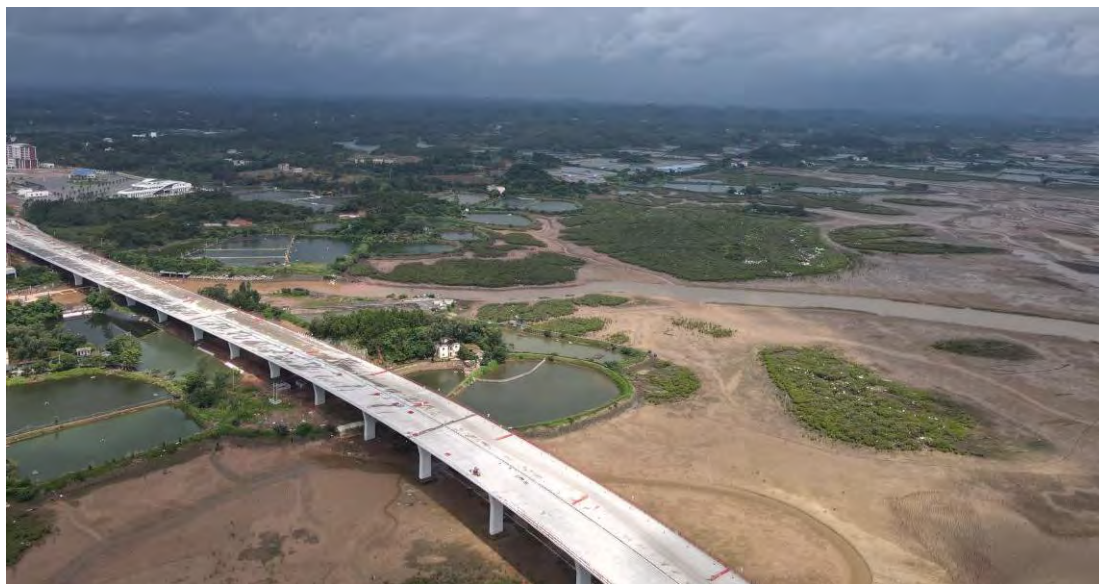
图 5.1.2-1b 本项目红树林修复区现状（从东南向西北拍摄）
