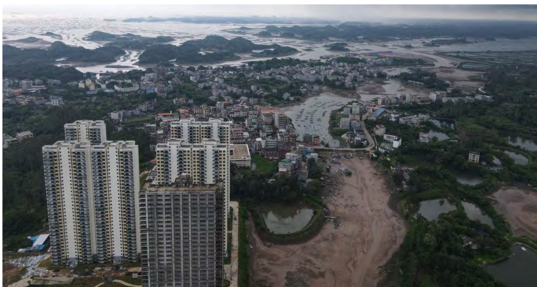
图 5.1.2-1e 本项目潮汐通道疏通工程中用海区现状（从北向南拍摄）
