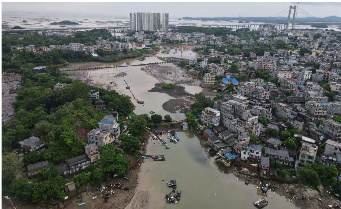
图 5.1.2-1d 本项目潮汐通道疏通工程中用海区现状（从南向北拍摄）
