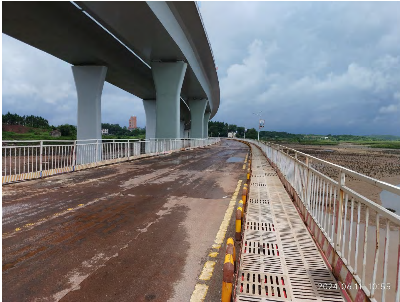
图 5.1.3-1 国道 G228 丹东至东兴广西滨海公路龙门大桥工程及其施工便桥现场照片
