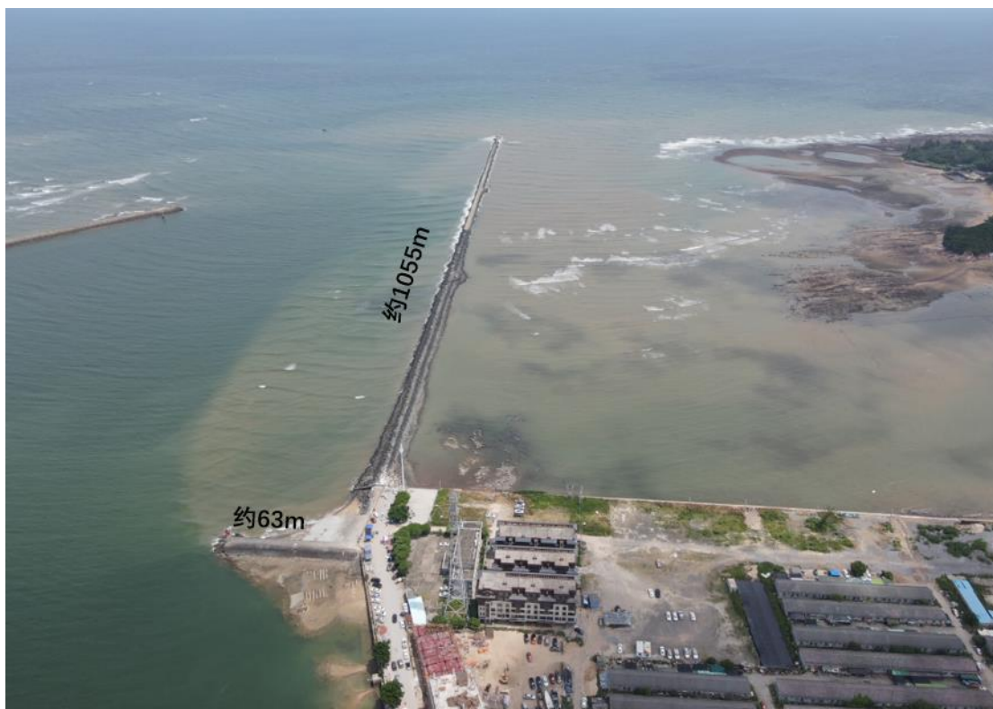
图 2.1-5 已建防波堤工程照片 3 (2024 年 8 月 9 日)
