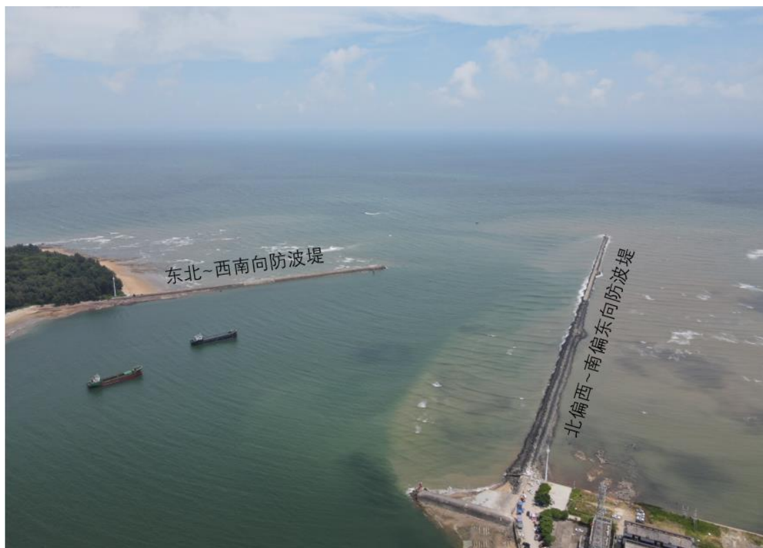
图 2.1-3 已建防波堤工程照片 1 (2024 年 8 月 9 日)
