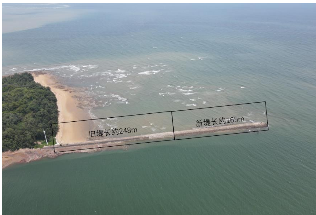
图 2.1-4 已建防波堤工程照片 2 (2024 年 8 月 9 日)
