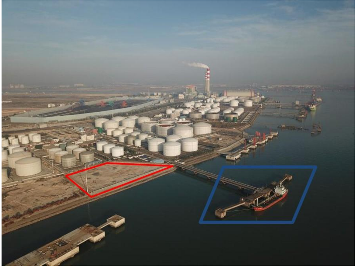
图 8.6-12 港池疏浚建设后船舶停靠情况（修复后）
